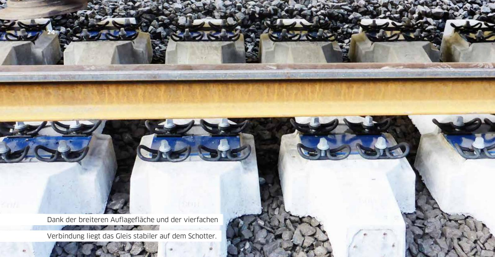
Dank der breiteren Auflagefläche und der vierfachen Verbindung liegt das Gleis stabiler auf dem Schotter.
