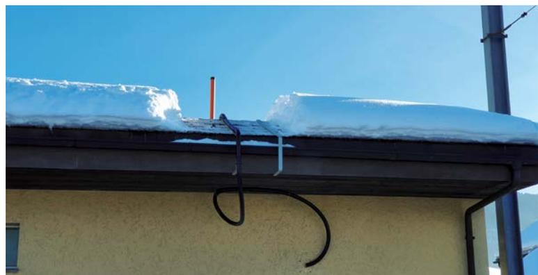
Dank einer direkten Speisung ist der IoT-Sensor immer mit Strom versorgt.
