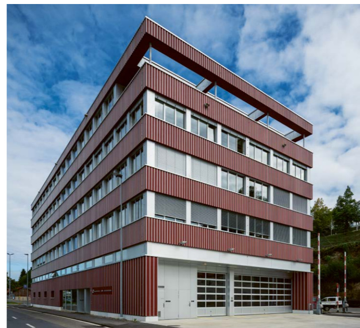
Im neuen Verwaltungsgebäude der AB arbeiten drei Unternehmen des öffentlichen Verkehrs unter einem Dach und zwei Betriebszentralen in einem Raum.
