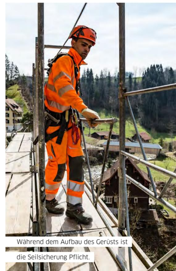
Während dem Aufbau des Gerüsts ist die Seilsicherung Pflicht.
