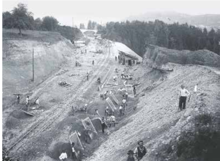
Die Mogelberger Schleife wird gebaut.
